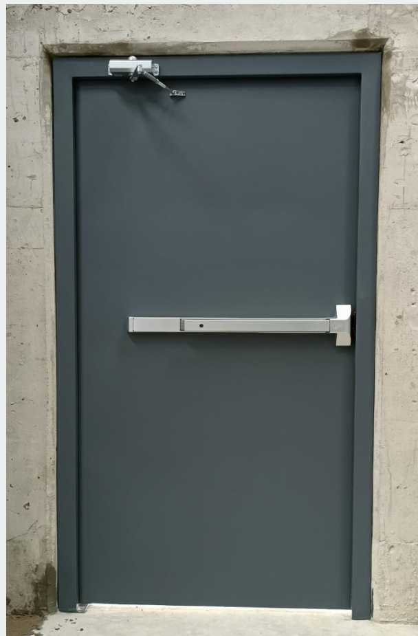
Puerta de Salida de Emergencia instalada en San Francisco Totoltepec Edo. Mex.
